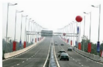
Hình 7.31. Các cây cột đèn có phương thẳng đứng nên không vuông góc với mặt dốc.
