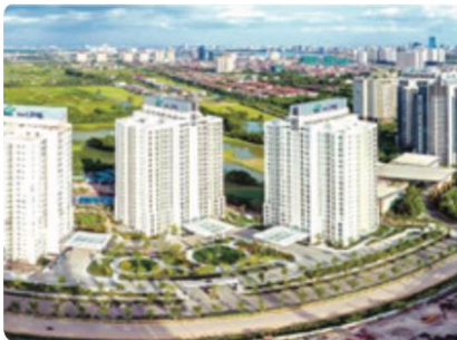
Hình 1.12. Không gian Khu đô thị mới quận Bắc Từ Liêm
