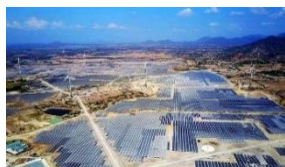
Nhà máy điện mặt trời Trung Nam Thuận Bắc 450 MW lớn nhất Việt Nam.
