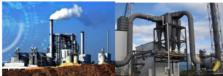
Hệ thống hút bụi công nghiệp cyclone để xử lý bụi giấy.
