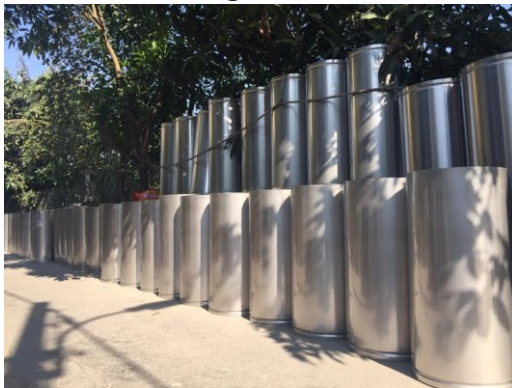
Hệ thống ống thoát rác
